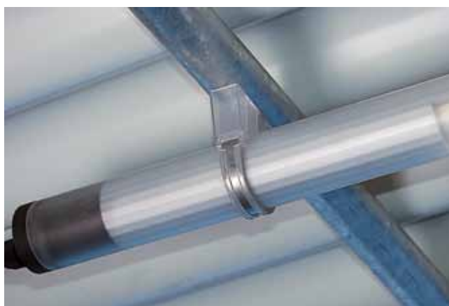
Detail dakconstructie met verlichting
