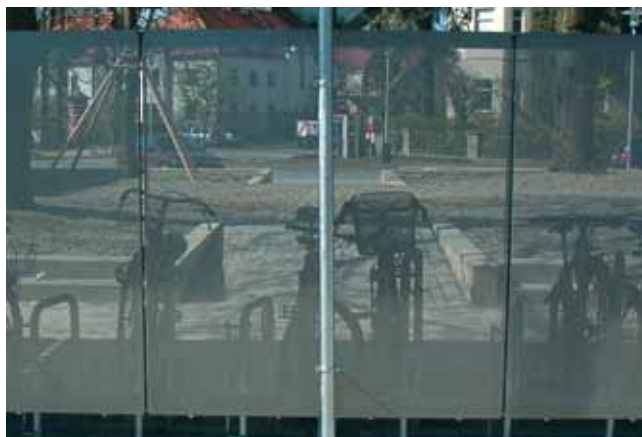
Overkapping met geperforeerde RVS wanden
